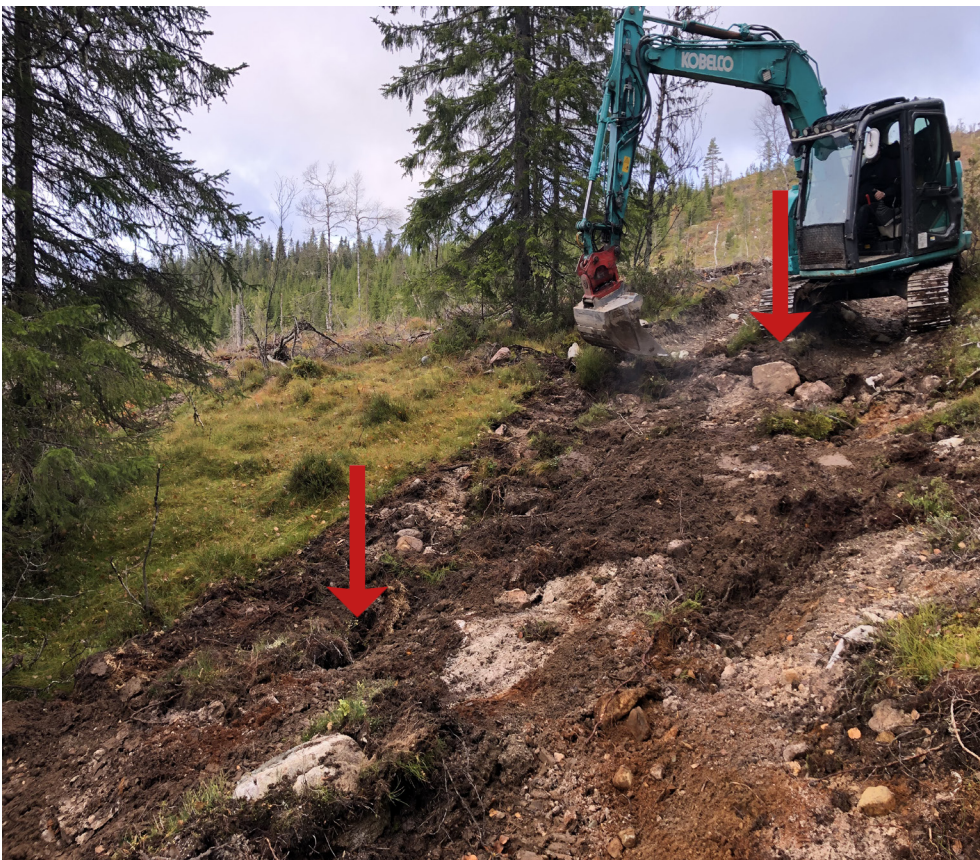
Basveg etter oppretting med oppstikkende steiner og små søkk. Foto: Trygve Øvergård
