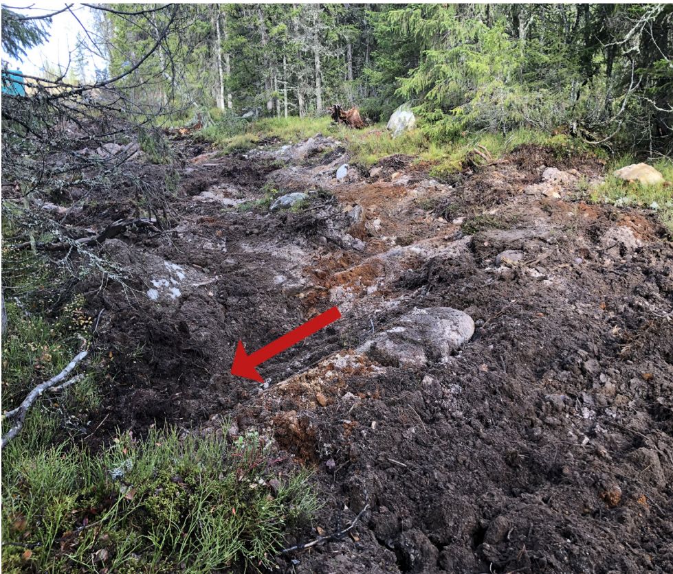
Der basvegen går i hellende terreng er det viktig å lage forsenkninger for å lede vann ut i terrenget og på den måten forebygge erosjon. Foto: Trygve Øvergård
