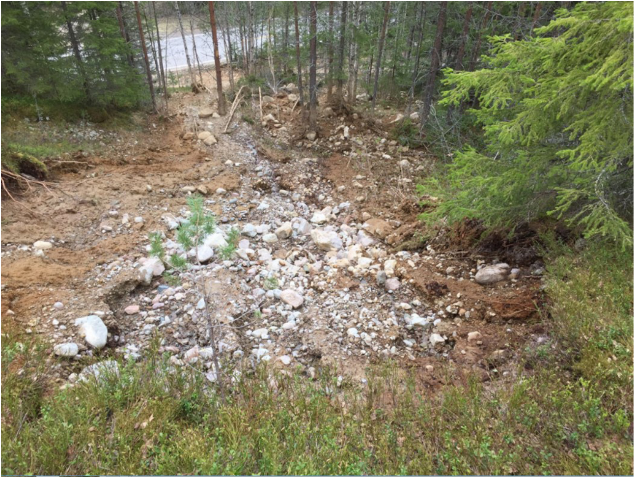
Løsmasseskred utløst av erosjon i basveg ned mot en offentlig veg. Foto Trygve Øvergård
