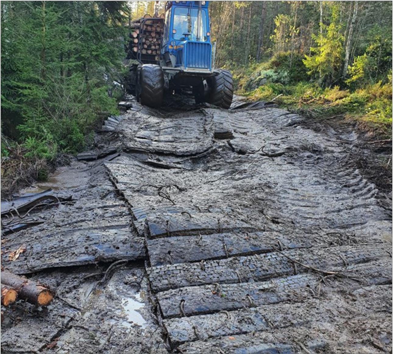
Bruk av gummimatter istedenfor klossing. Foto: Thoralf Halvorsrud
