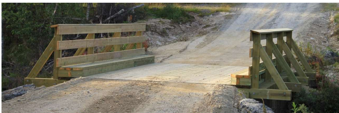
Bilde 9: Stålbjelkebru med tredekke.
