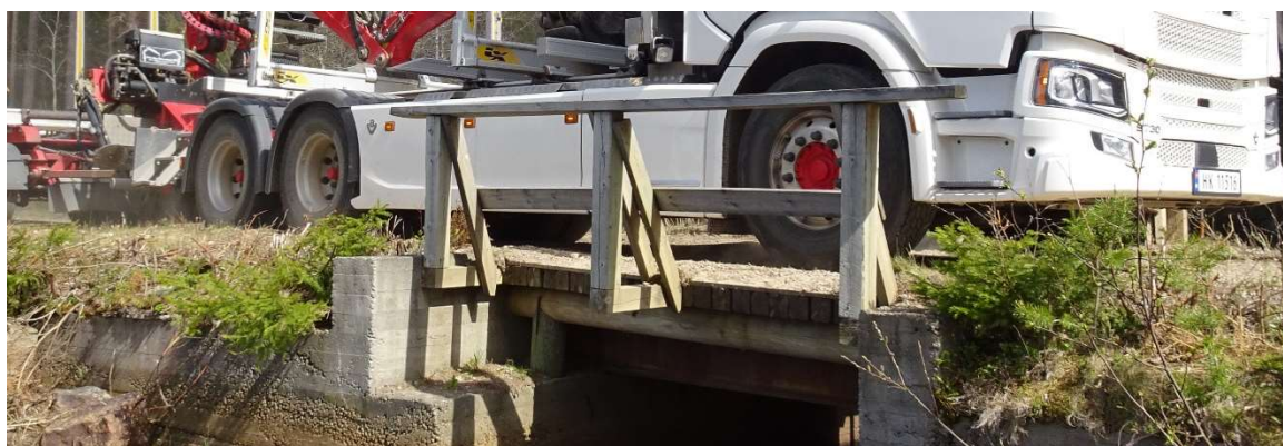
Bilde 13: Svakheterne ved bruer og kulverter på skogsbilveger er knyttet til aksellast og ikke totalvekt.
