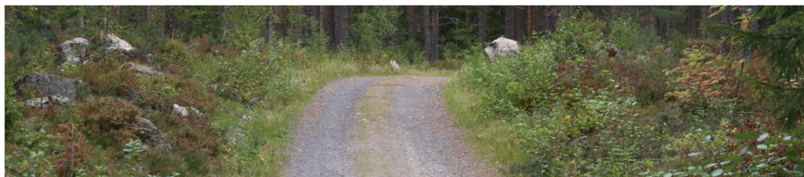
Bilde 5: Bulldoserbygd skogsbilveg.
