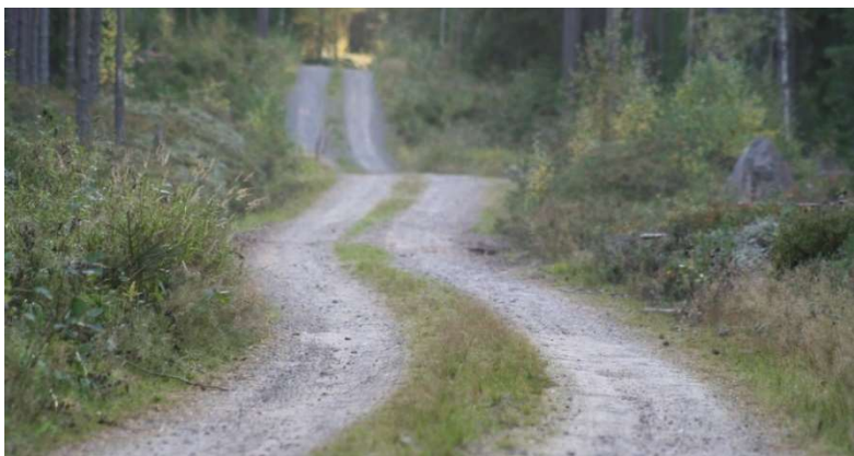
Bilde 15: Skogsbilveg med potensiale for lav hastighet.
