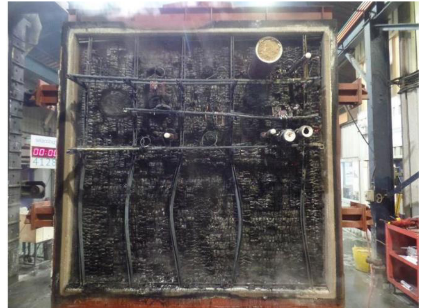
Brannutsatt side av massivt tre element (3m x 3m) branntettet med Protecta produkter
