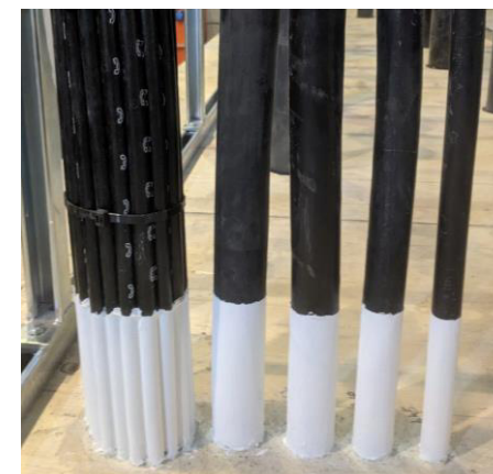
Typiske gjennomføringer med lysåpning mellom 10 og 20mm
