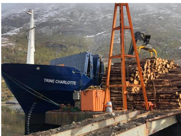
Figur 3h. Gruset lasterampe med rampens vinsjetårn.
