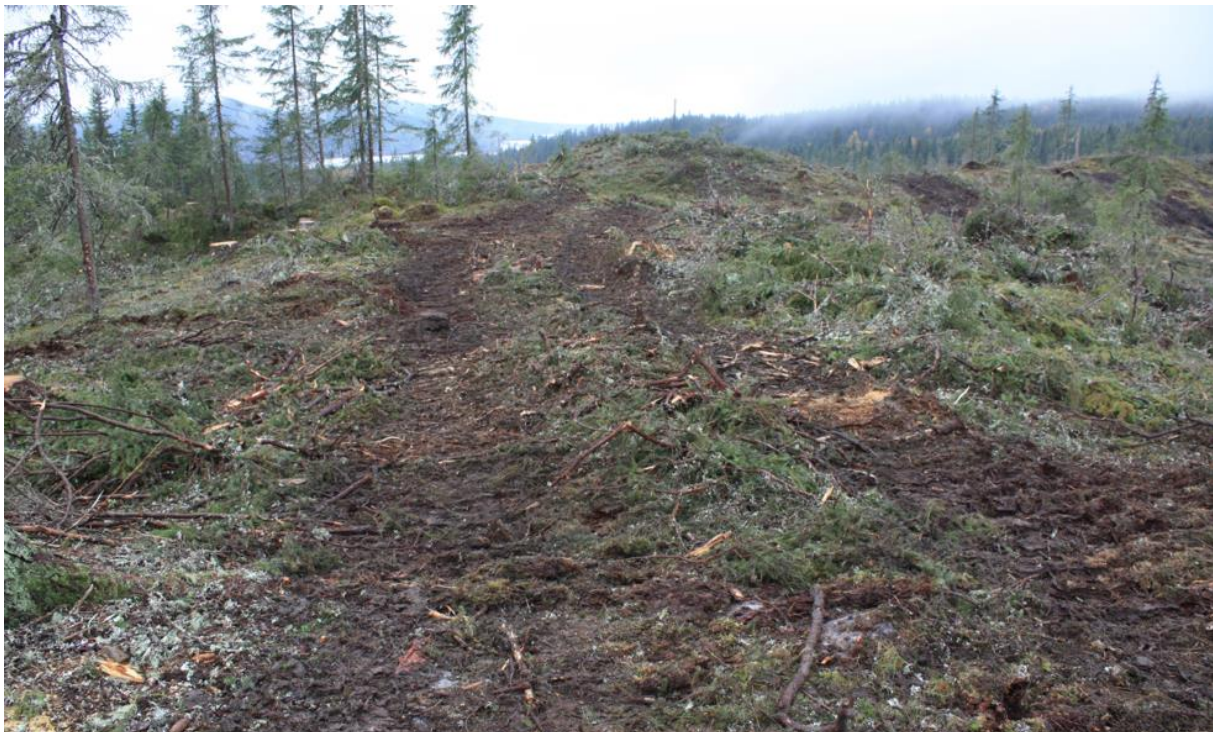
Figur 27. Dette er basvegen til venstre i fig. 24. Den er lagt oppe på en esker i terrenget. Steinholdig og tørr mark gir terrengskader med nedsynking under 10 cm. De er verken skjemmende, hindrer framkommelighet eller kan føre til erosjon og vannavrenning.
